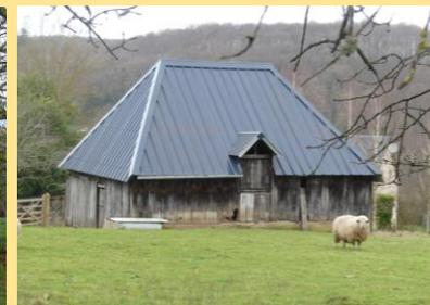
*La tuile à emboîtement dite « tuile mécanique » ou la tôle d'acier nervurée peuvent être des solutions provisoires pour sauver le bâti rural*
