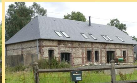
Bien que bien positionnés en bas du rampant, dans le nu du toit, de taille modeste, alignés horizontalement et en lien avec les travées de la façade, ces châssis de toit sont trop nombreux et trop rapprochés, créant une présence trop forte en toiture.
