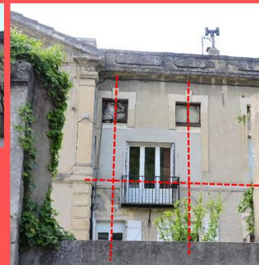
Exemple de percement réalisé de façon incohérente et sans aucun lien avec les trames architecturales existantes : sur une façade à travées régulières, la baie prend place entre deux travées, en rebouchant deux baies anciennes, au milieu du bandeau de façade. Les proportions de la nouvelle baie n'ont rien à voir avec celles des baies anciennes.
