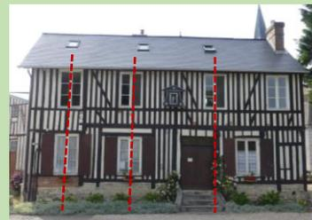
La petite taille des châssis de toit et leur implantation dans l'axe des travées de façade les rend discrets dans la composition d'ensemble
