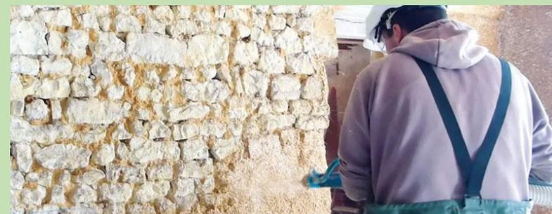
Projection d'un enduit chaux-chanvre sur murs en maçonnerie, pour une correction thermique des murs évitant l'effet « paroi froide », souvent suffisante en bâti ancien
