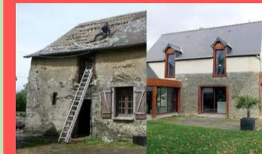
Exemples de transformation de grange ayant fait perdre tout intérêt patrimonial, par la multiplication et la disproportion des ouvertures, le traitement des enduits, le PVC et le parpaing... La construction ancienne devient illisible ou pavillon standard.
