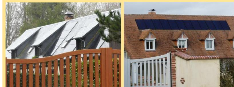
*Même sur l'ardoise dont la couleur est proche, les panneaux solaires ou photovoltaïques, plus brillants et uniformes, restent visibles. Leur implantation doit donc être soignée afin d'avoir le moins d'impact possible dans les paysages. Sur la tuile, les panneaux sont d'autant plus visibles.*
