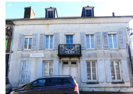
Balcon filant au premier étage ou centré sur la façade, avec garde-corps en ferronnerie : des exemples anciens servant d'inspiration.
