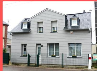
L'isolation par l'extérieur, réalisée ici avec des bardages PVC, a un impact fort sur la perception de l'architecture et peut provoquer des désordres
