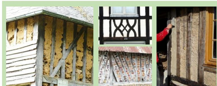
Pans-de-bois avec remplissage terre et bardages bois, enduit chaux, remplissage en briques. Rénovation avec remplissage chaux/chanvre
