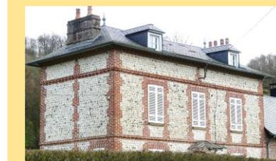
Les maisons de maître en maçonnerie étaient mises en valeur par la présence d'un enduit. Rendre apparents des moellons de pierre qui n'étaient pas fait pour être vus à tendance à déstabiliser la cohérence et la régularité de la façade.
